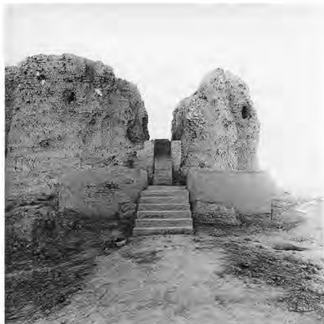
22. Les escaliers de la deffufa après les dernières restaurations
