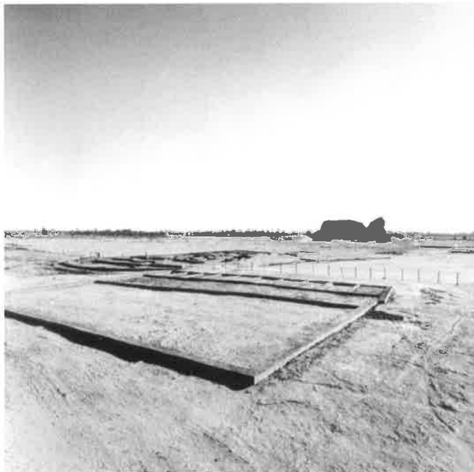
9. Les magasins et le palais après les restaurations (photo D. Berti).
